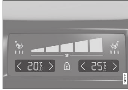
Tünel konsolunun arka tarafındaki klima panelindeki sıcaklık kumandası.
