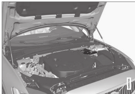
Pomocná baterie se nachází v motorovém prostoru.
