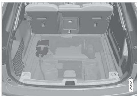
若車輛是配備 48V 支援電瓶，則位於行李廂左側。48V 支援電瓶僅限由授權服務廠處理。
