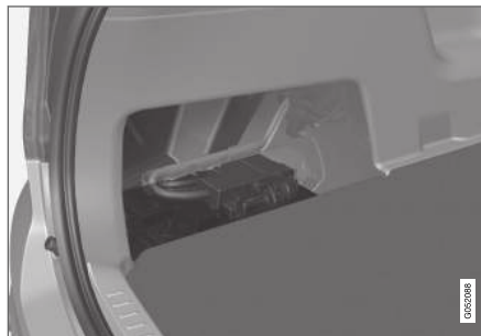
Startbatteriet sitter i bagasjerommet.
