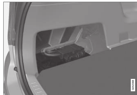
Startbatteriet är placerat i lastutrymmet.
