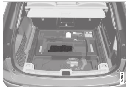
Startbatteriet är placerat i lastutrymmet.
