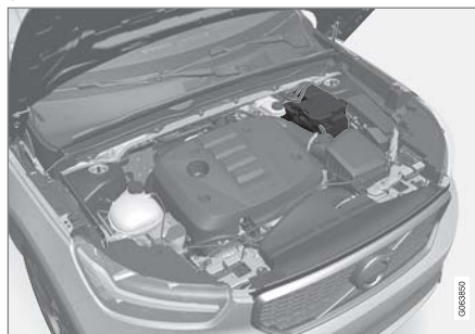
起動電瓶位於引擎室中。
