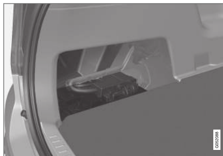
La batterie de démarrage se trouve dans le compartiment à bagages.
