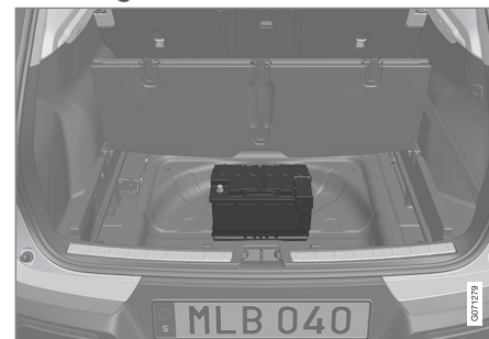
Startbatteriet er placeret i bagagerummet.
